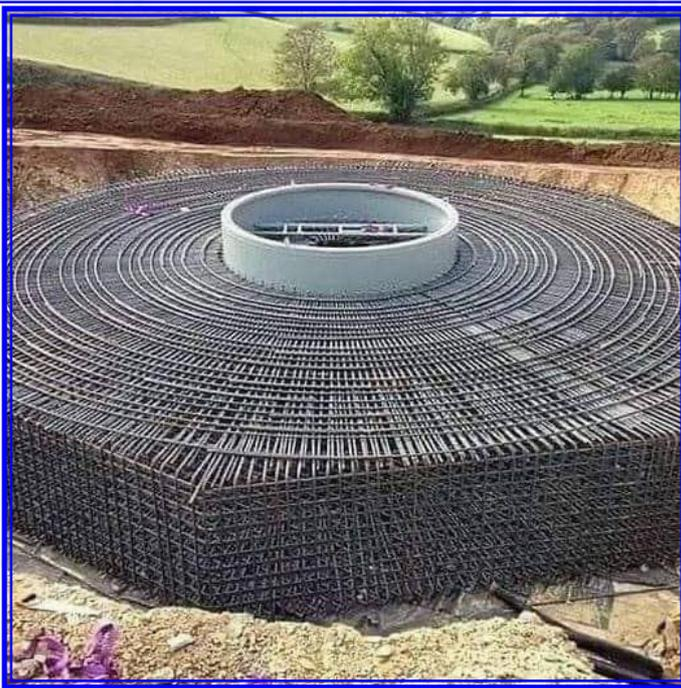
Cette photo représente l'armature en acier utilisée dans la base d'une éolienne. Pour la compléter, il faut encore ajouter entre 600 et 800 mètres cubes de béton, soit un poids de près de 2000 tonnes.
